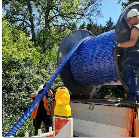
↑ Trommel aufstellen (z. B. Trommel T210 auf Gestell)
